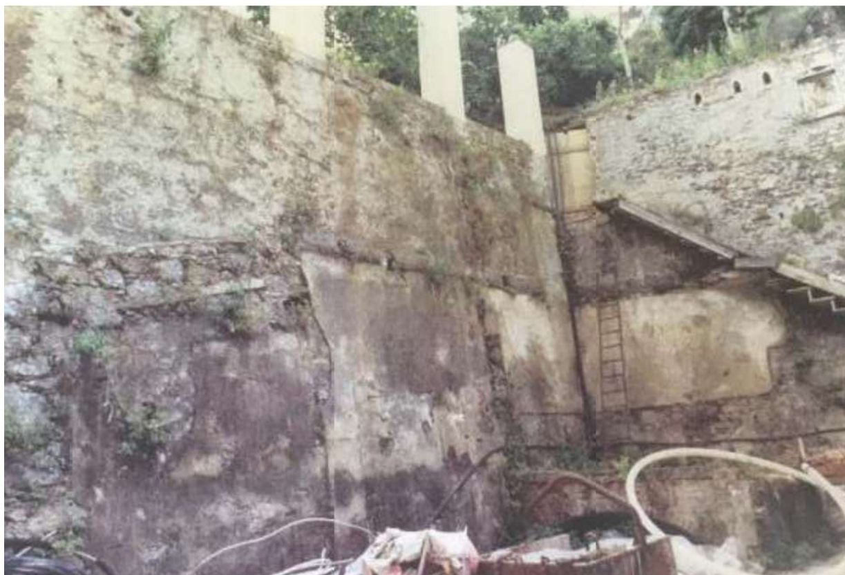
Viste ravvicinata del muro a monte cavedio interno
