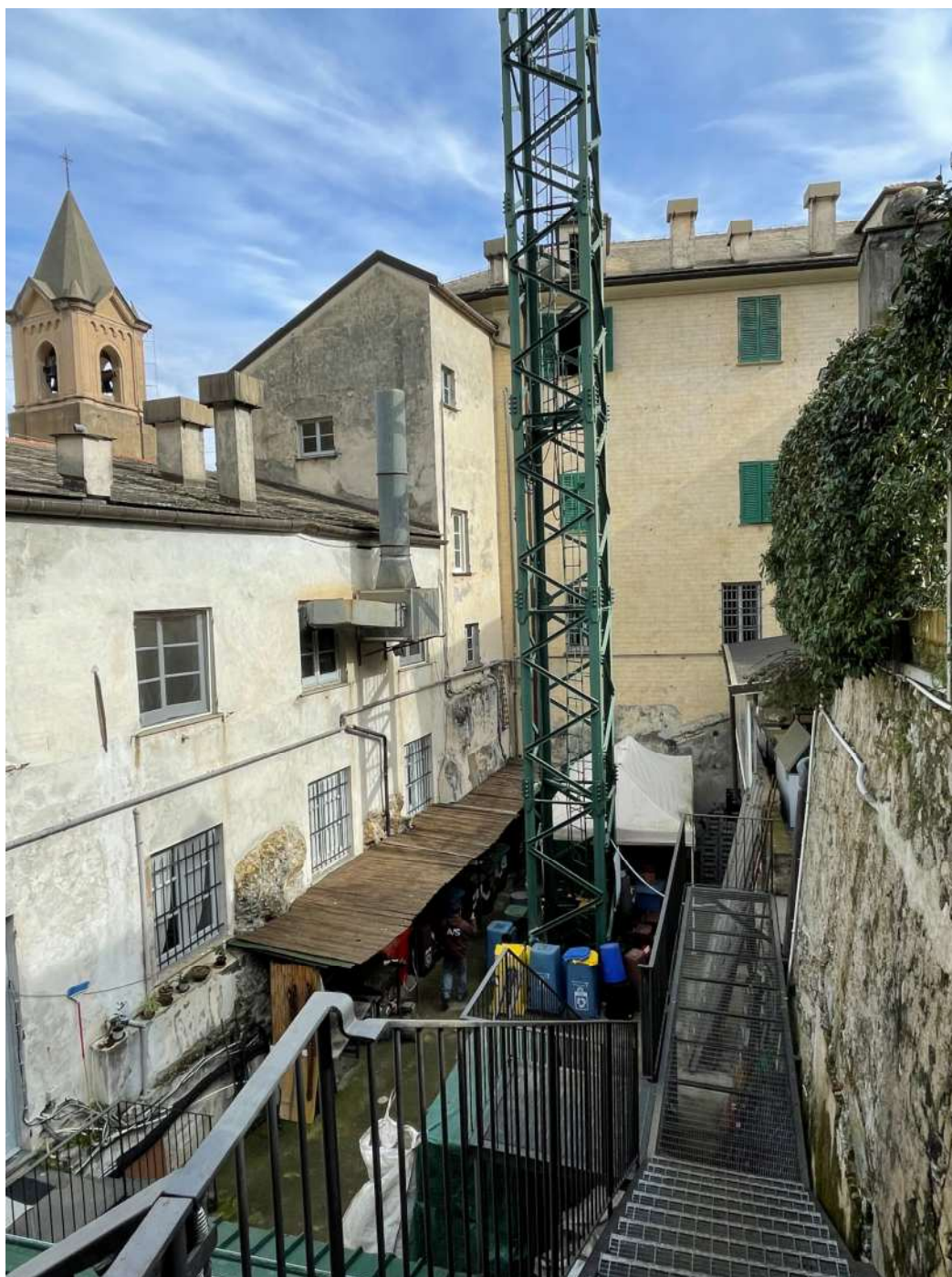
Ripresa fotografica del cavedio interno ove è prevista la realizzazione del corpo cucina
