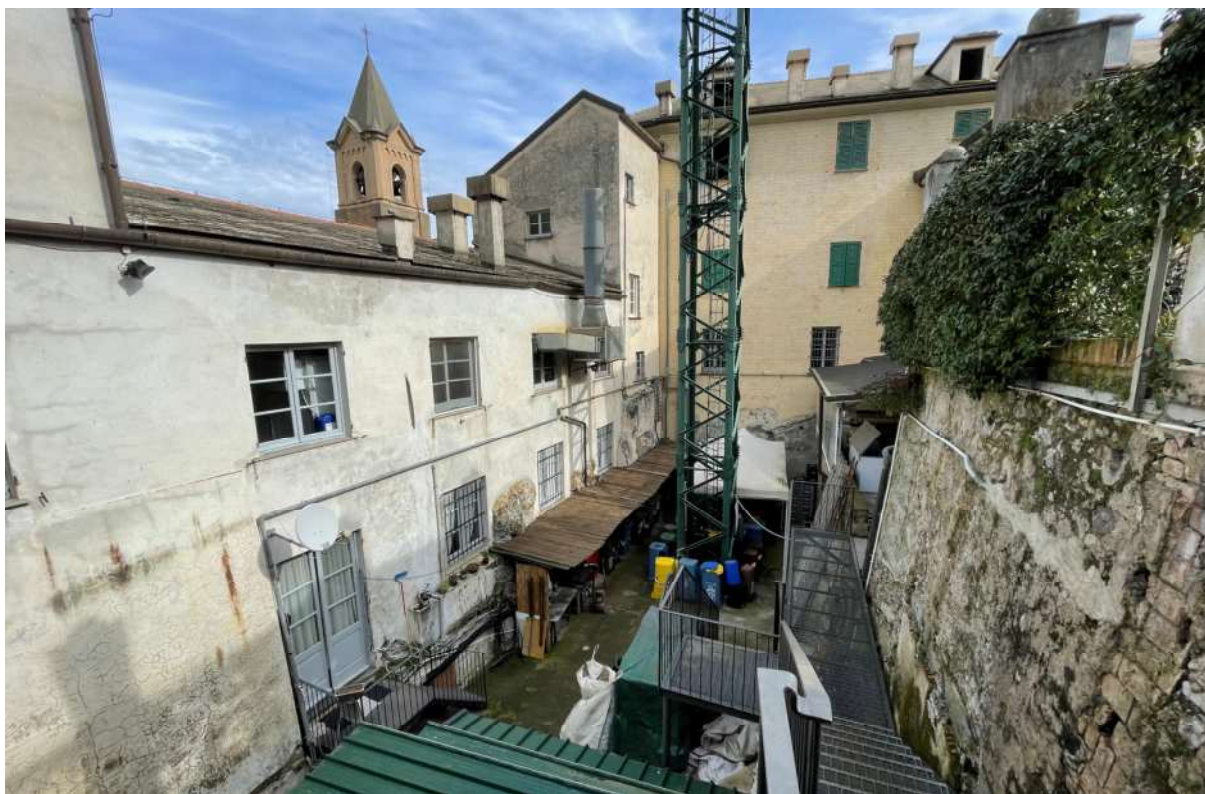
Vista d'insieme del cavedio interno – ripresa da monte
