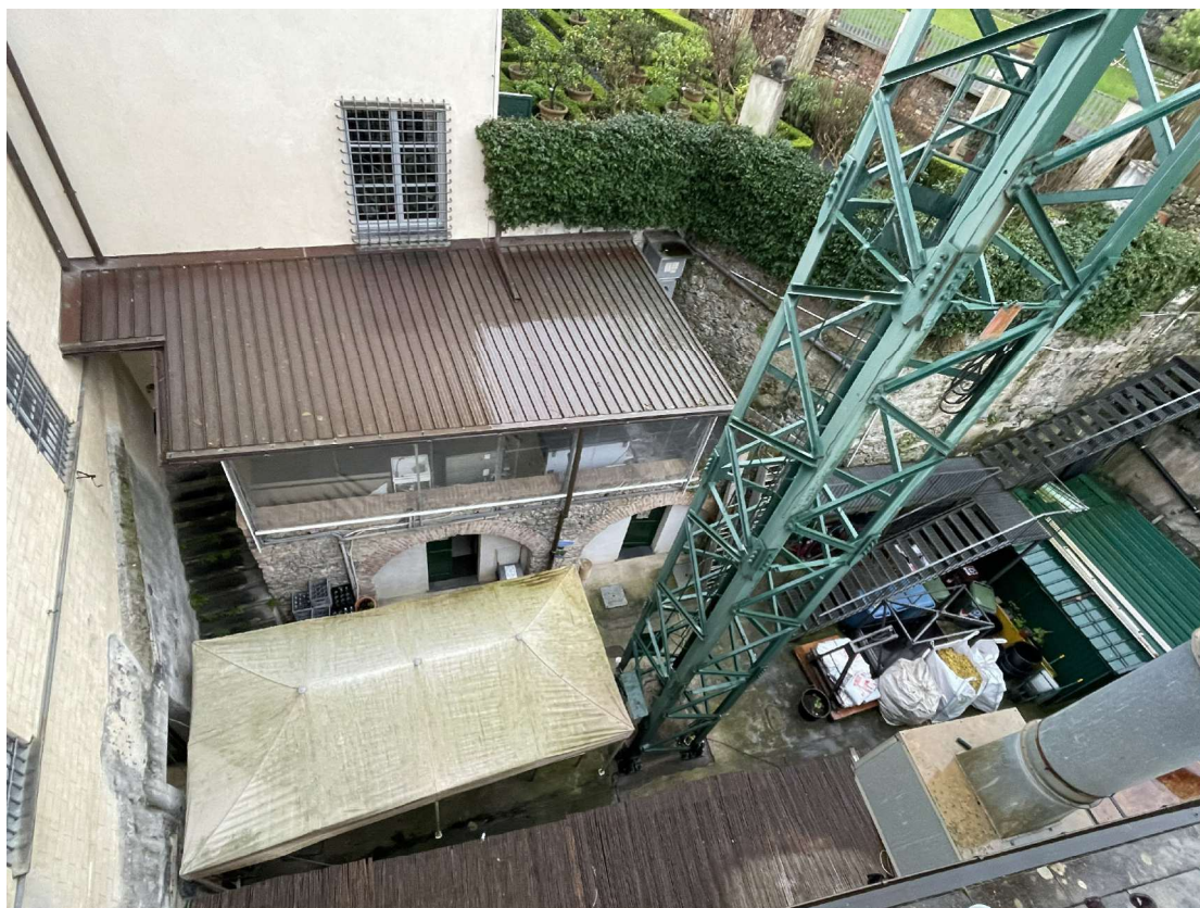
FOTO 08 - CAVEDIO INTERNO - AREA NUOVE CUCINE
