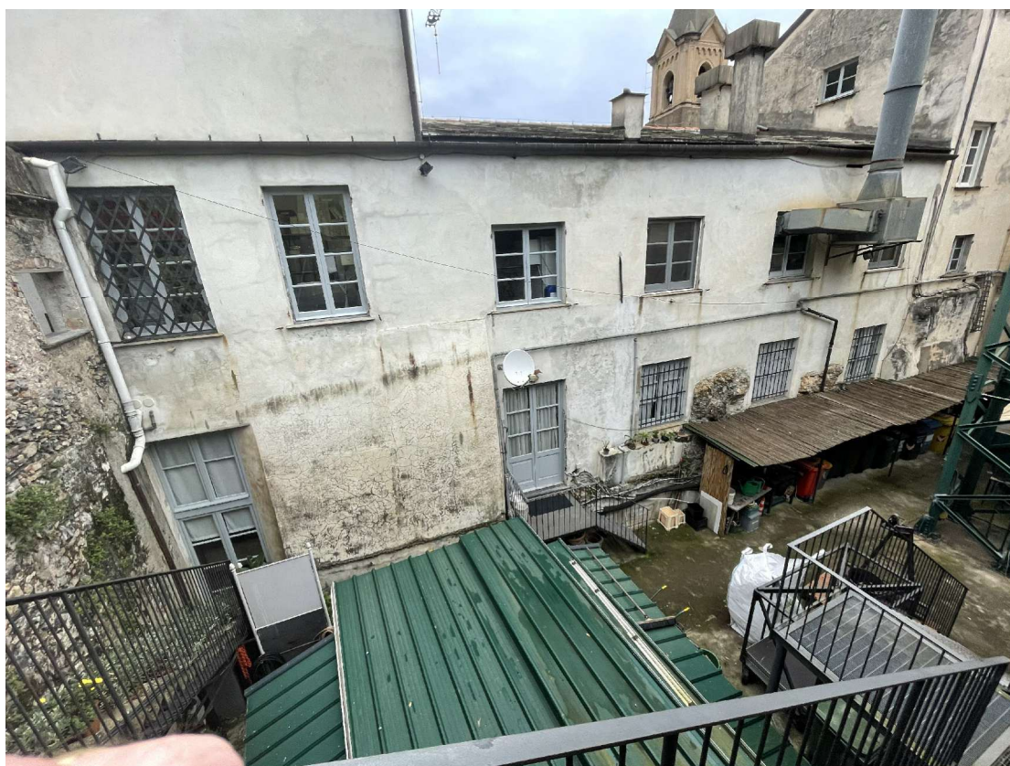
FOTO 10 - CAVEDIO INTERNO - AREA NUOVE CUCINE
