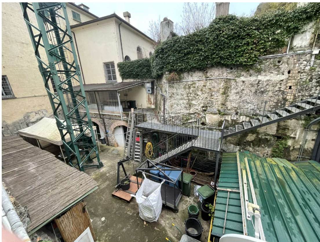
FOTO 12 - CAVEDIO INTERNO - AREA NUOVE CUCINE
