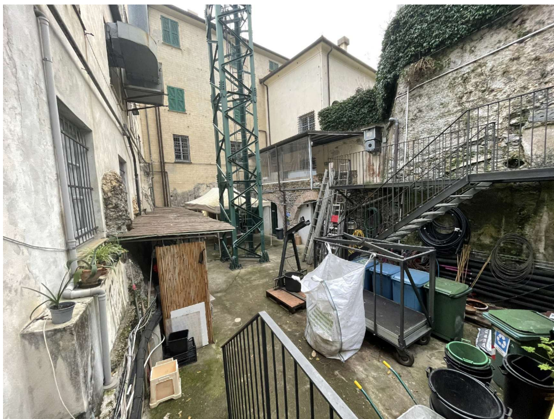
FOTO 09 - CAVEDIO INTERNO - AREA NUOVE CUCINE
