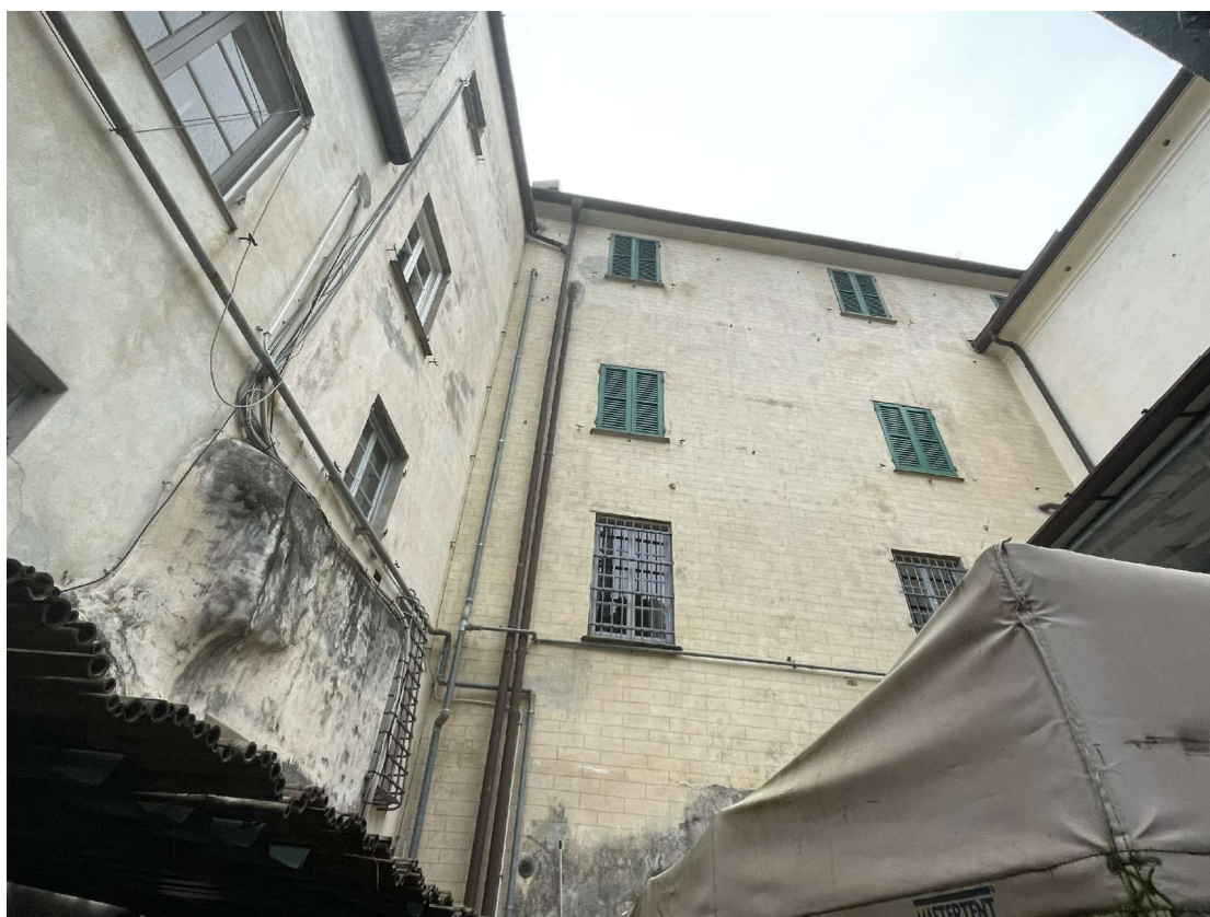
FOTO 14 - CAVEDIO INTERNO - AREA ASCENSORE
