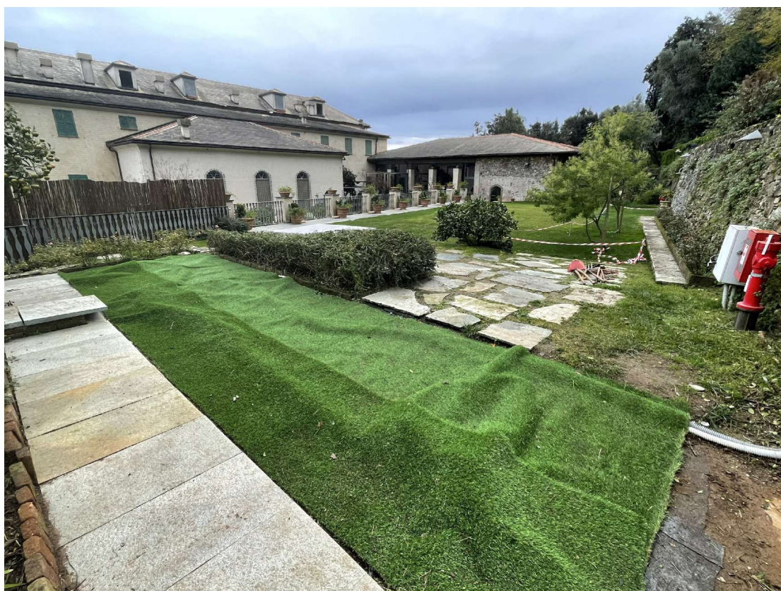
FOTO 04 - AREA INSTALLAZIONE SERRA LATO MONTE
