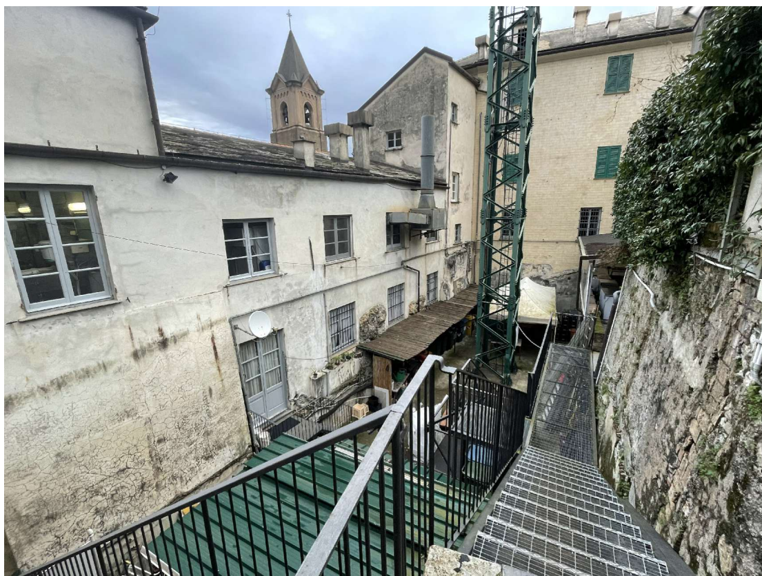
FOTO 11 - CAVEDIO INTERNO - AREA NUOVE CUCINE
