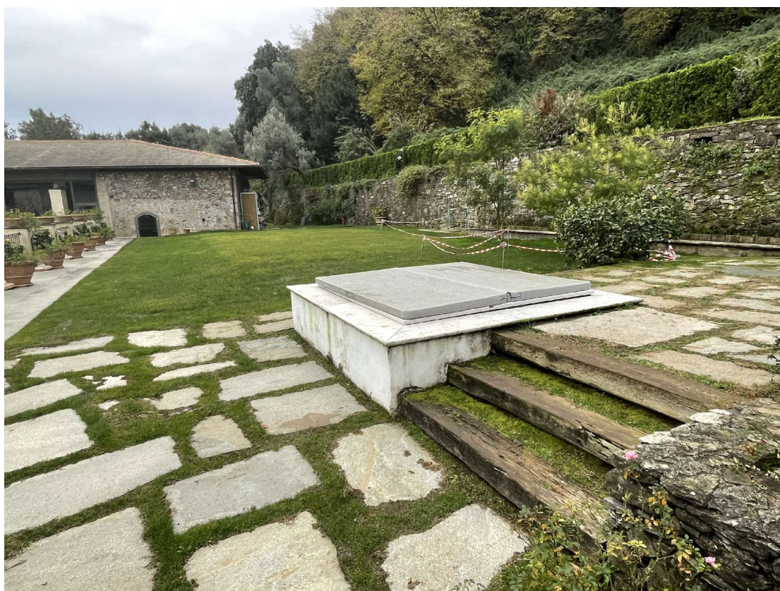
FOTO 06 - AREA INSTALLAZIONE SERRA LATO MONTE
