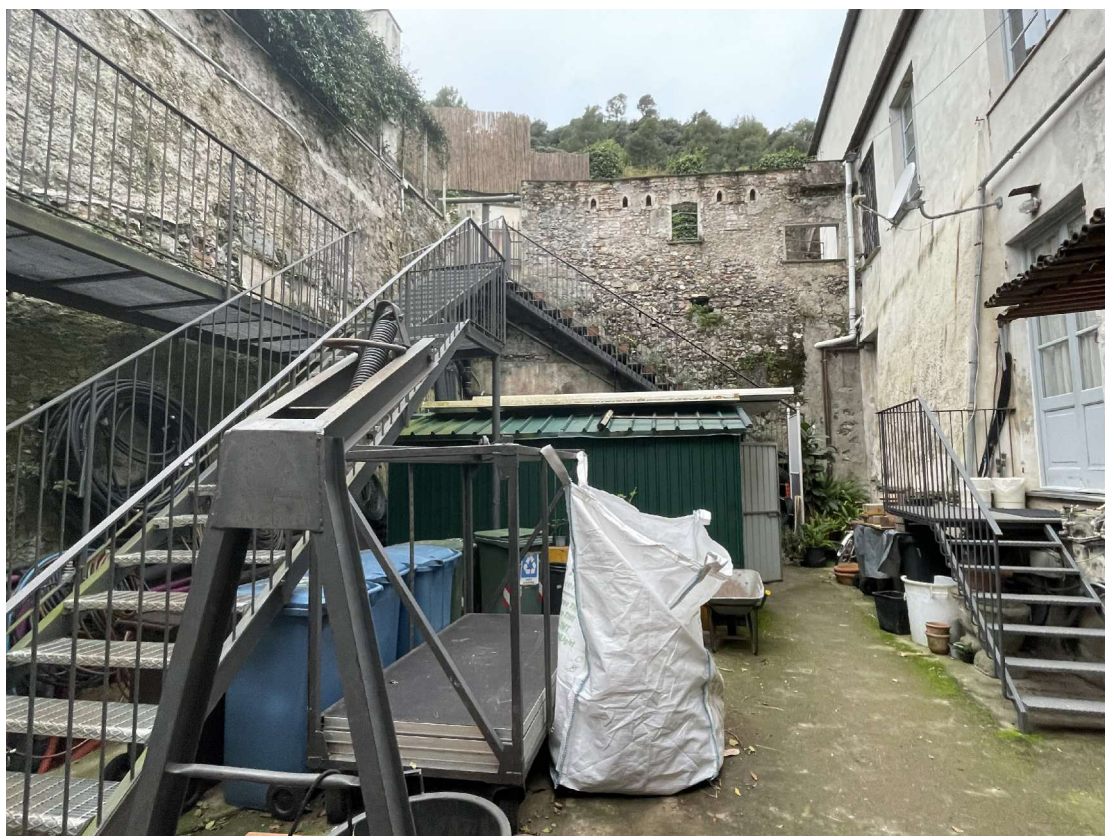
FOTO 13 - CAVEDIO INTERNO - AREA NUOVE CUCINE
